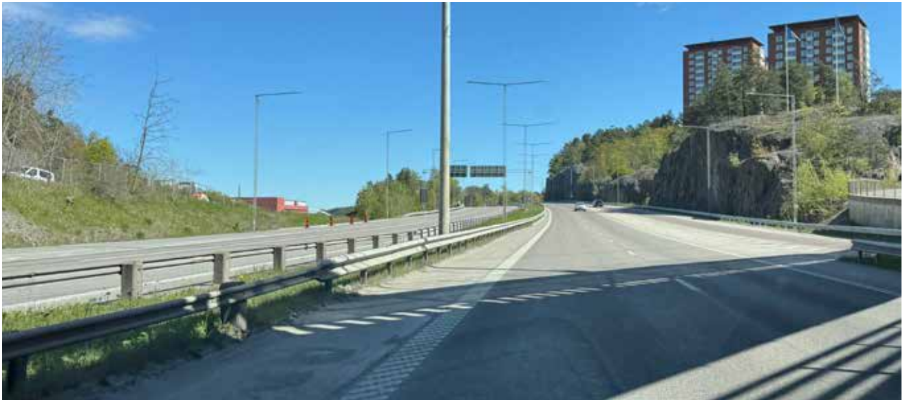
Broläget sett från väster där landfästet i söder kommer att ligga mellan de två byggnaderna på berget.
